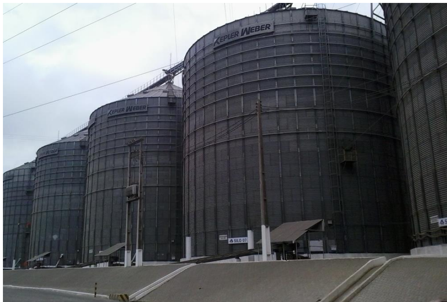
Figura 12 - Silos de armazenamento
