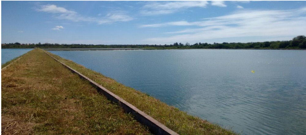
Figura 3.11 - Lagoa de estabilização ETE 4. Região Metropolitana de Fortaleza, Ceará. 2017
