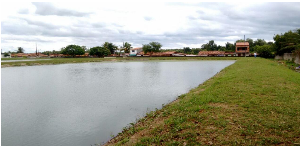
Figura 3.10 - Lagoa de estabilização ETE 3. Região Metropolitana de Fortaleza, Ceará 2017
