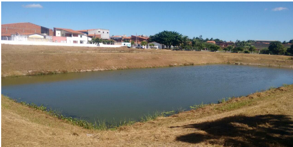
Figura 3.9 - Lagoa de estabilização ETE 2. Região Metropolitana de Fortaleza, Ceará. 2017
