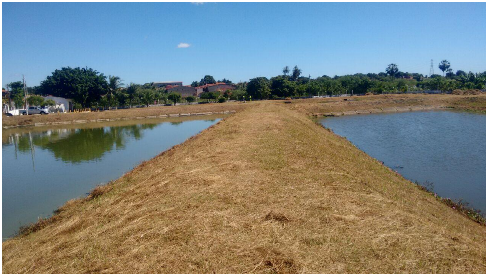
Figura 3.12 - Lagoa de estabilização ETE 6. Região Metropolitana de Fortaleza, Ceará. 2017
