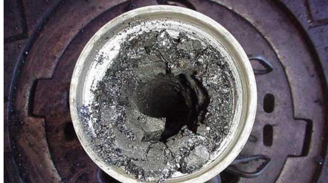
Figura 5 - Asfalteno depositado em uma tubulação.
