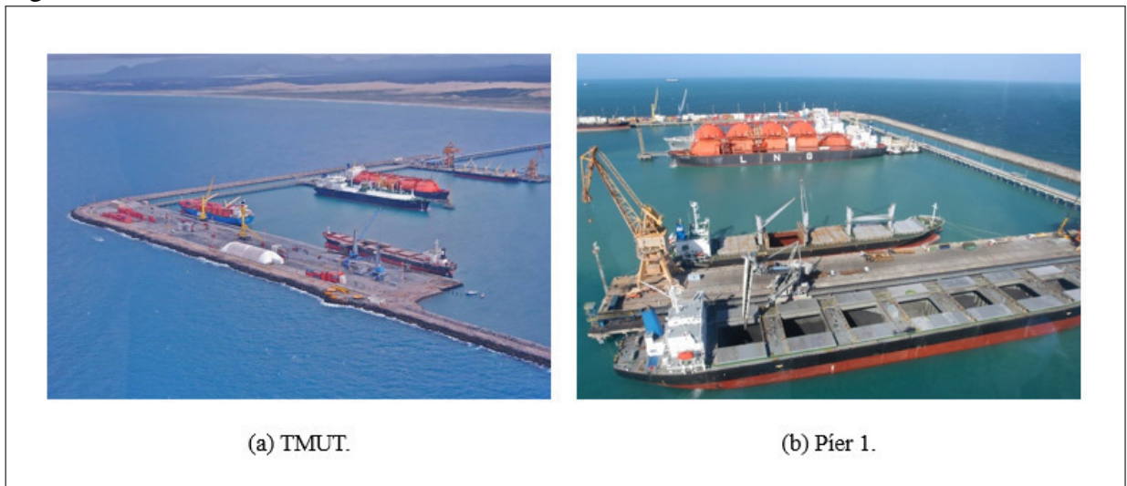
Figura 1 – Vistas aéreas do Porto do Pecém.
