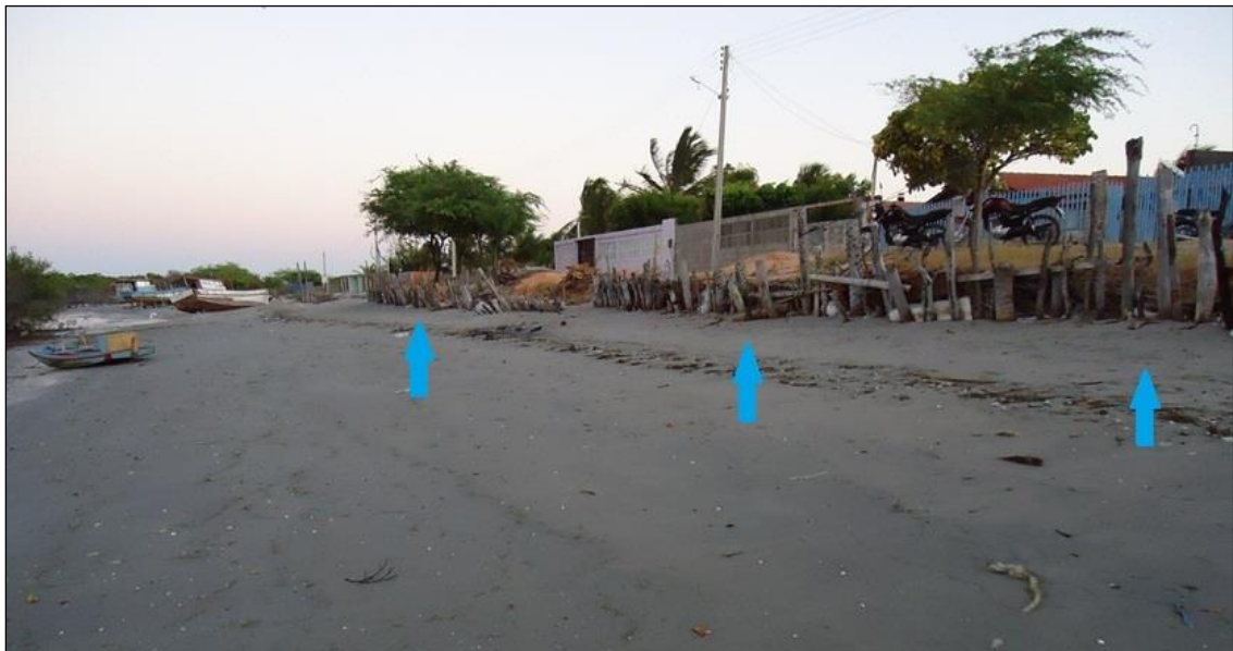
FIGURA 09: Estruturas improvisadas para contenção da erosão na Praia de Requenguela, Icapuí, indicadas pelas setas azuis. Atente-se para a proximidade das casas e via de acesso em relação ao mangue e à faixa entre marés, observando a “linha de deixa” formada pela ação das marés, equivalente à preamar daquele dia. Fonte: Pesquisa de Campo, 2011.
