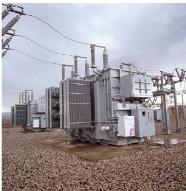
Figura 2.8 - Transformador "abaixador"
