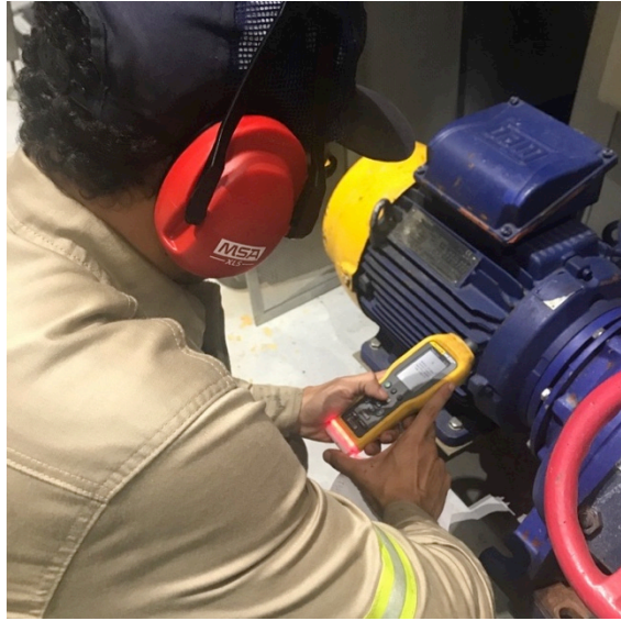
Figura 11: Medição de vibração em um motor
