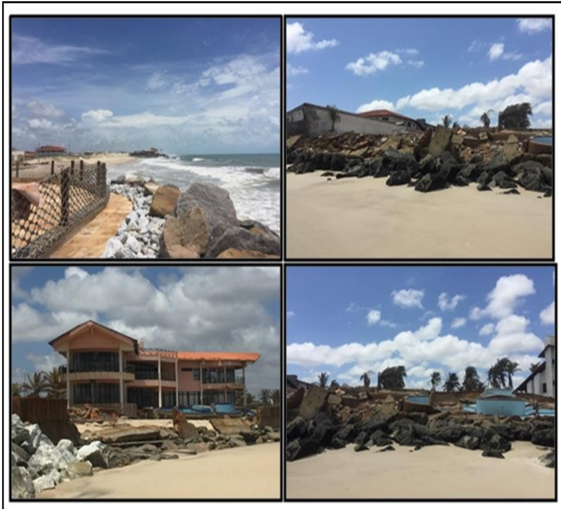
Figura 23 - Destruição de infraestruturas da praia da Caponga.
