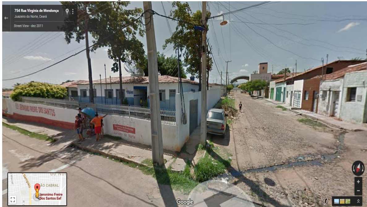
Figura 6: Lateral da escola sem cerca elétrica
