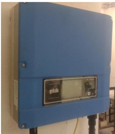
O inversor instalado junto aos painéis FV foi o PHB1500-SS, Figura 15, com os principais dados elétricos mostrados na Tabela 02.
