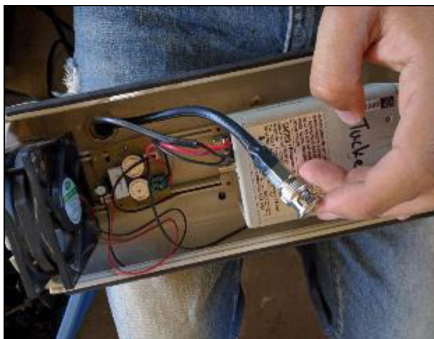
Figura 7 – Instalação das câmeras.
