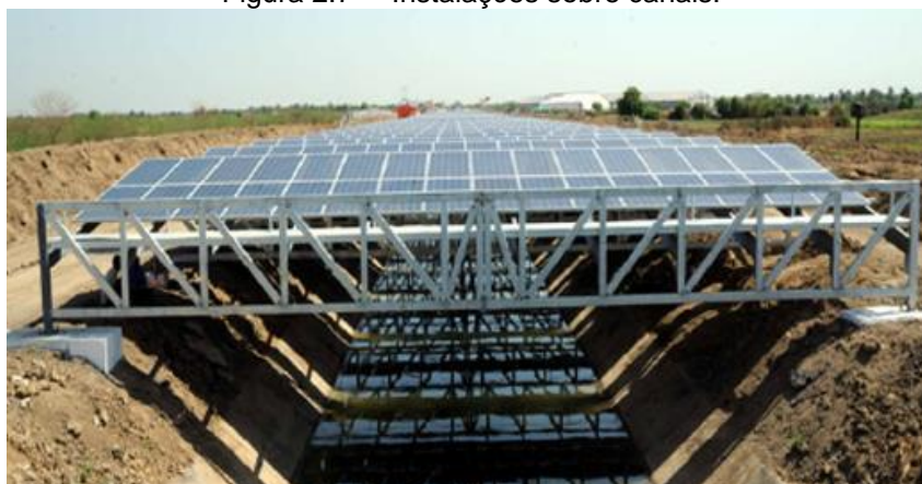
Figura 2.7 – Instalações sobre canais.
