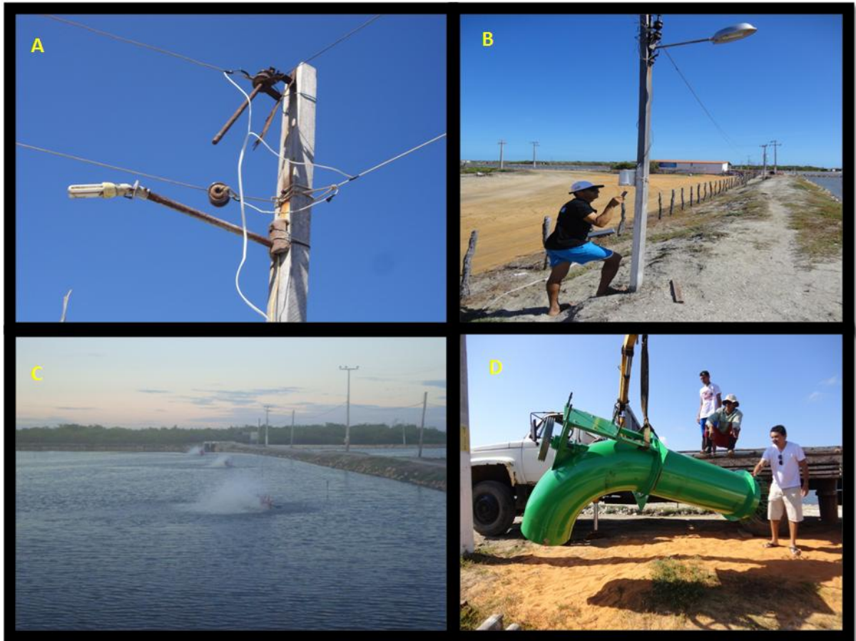
Figura 4- Utilização de Energia elétrica na ACCI. A: Fiação elétrica; B: Poste com luz elétrica ao longo de toda a fazenda; C: Aeradores em funcionamento em horários críticos para a produção; D: Bomba recém adquirida pela associação.
