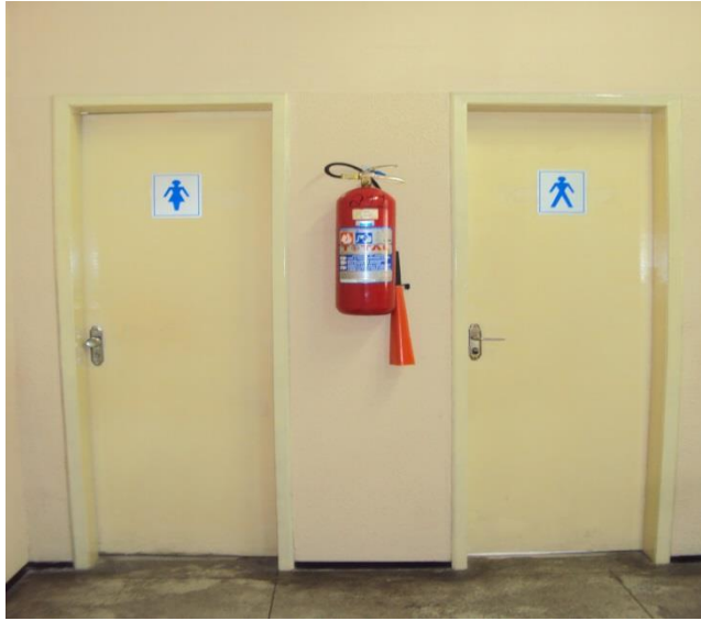
Figura 6 – Bloco Didático I - CAEN - Banheiros convencionais. Fonte: Pesquisa de Campo.
