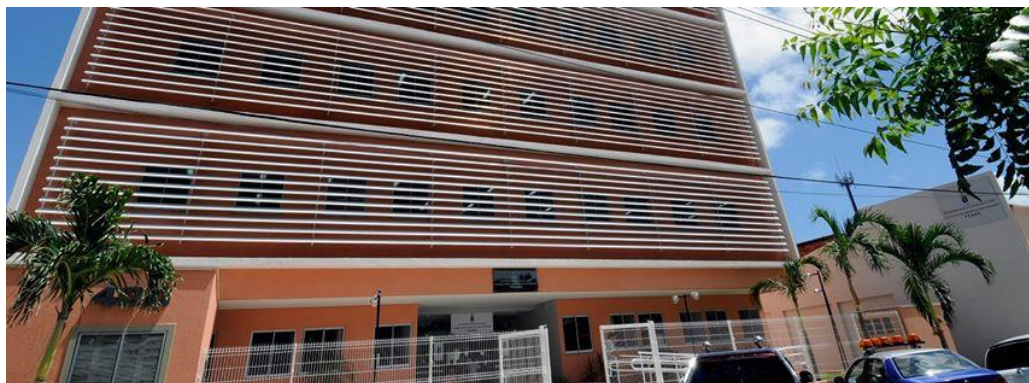
Figura 18 – Bloco Didático III – Rua Marechal Deodoro, 400 – Entrada Principal. Fonte: Internet.
