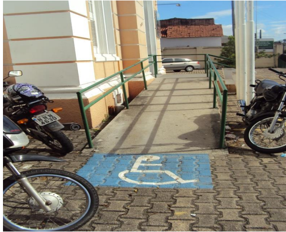
Figura 8 – Bloco Didático II – Rampa acessível com sinalização visual. Fonte: Pesquisa de Campo
