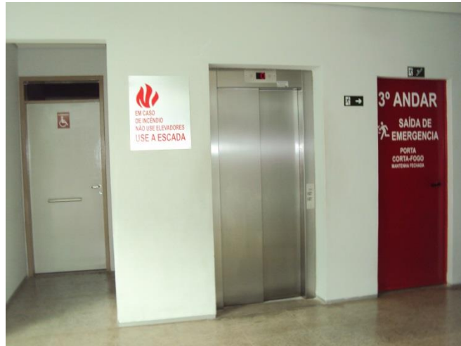
Figura 26 – Bloco Didático III da FEAAC – Banheiro acessível no 3º andar. Fonte: Pesquisa de Campo.
