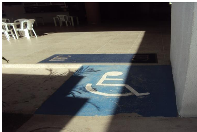
Figura 20 – Bloco Didático III – Mini-rampa acessível com sinalização visual. Fonte: Pesquisa de Campo.
