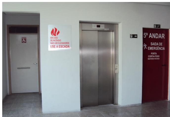
Figura 28 – Bloco Didático III – Banheiro acessível no 5º andar. Fonte: Pesquisa de Campo.
