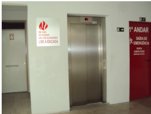
Figura 24 – Bloco Didático III – Banheiro acessível no 1º andar. Fonte: Pesquisa de Campo.
