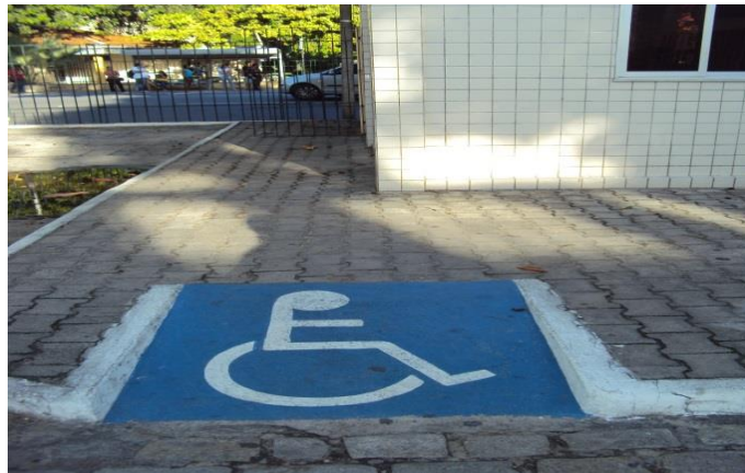
Figura 2 – Entrada ao CAEN – Rampa acessível com sinalização visual. Fonte: Pesquisa de Campo.
