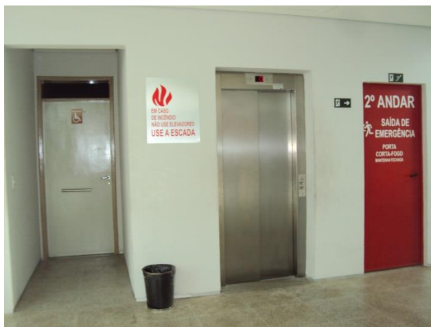
Figura 25 – Bloco Didático III – Banheiro acessível no 2º andar. Fonte: Pesquisa de Campo.
