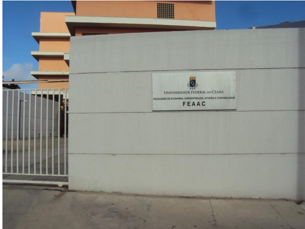
Figura 19 – Bloco Didático III – Rua Confúcio Pamplona. Entrada Secundária. Fonte: Pesquisa de Campo.
