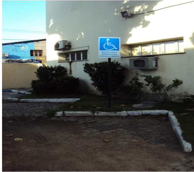
Figura 4 – Bloco Didático I – CAEN - Vaga de estacionamento com placa sinalizada. Fonte: Pesquisa de Campo.
