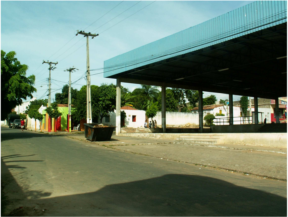
Figura 1 - Ruas do bairro Frei Damião, a esquerda escola “A” e à direita o Terreiro Ilê Axé Gitofalogi .
