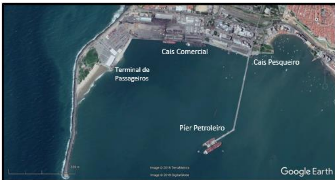
Figura 5– Instalações de acostagem do Porto de Fortaleza
