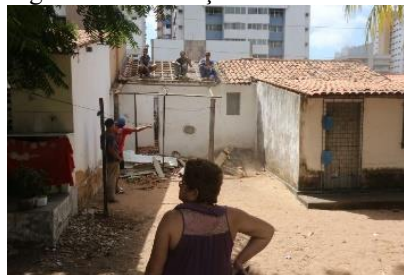
Figura 3 – Demolição de casas 2
