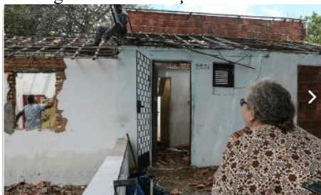
Figura 2 – Demolição de casas 1
