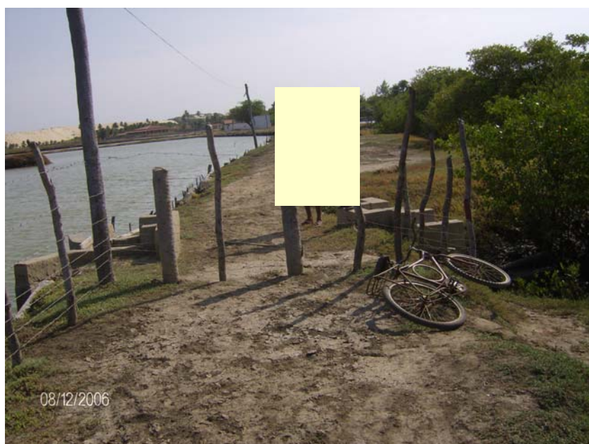
Figura 190 - Fazenda de camarão, construída no caminho que dá acesso ao mangue, obstrui a passagem de moradores da comunidade.
