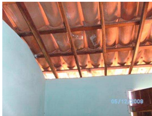
Foto 17. Garrafa PET utilizada como telha.
