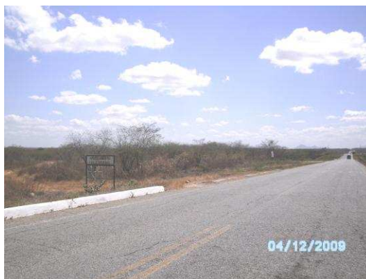
Foto 4. Placa indicativa da antiga entrada do Assentamento Boa Esperança- Lagoa da Manga na CE 55.
