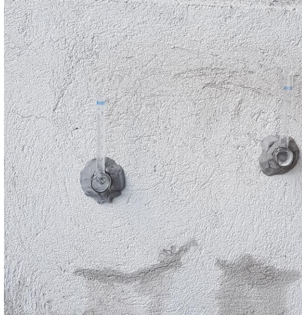
Figura 11 – Ensaio de permeabilidade em painel do traço de referência.
