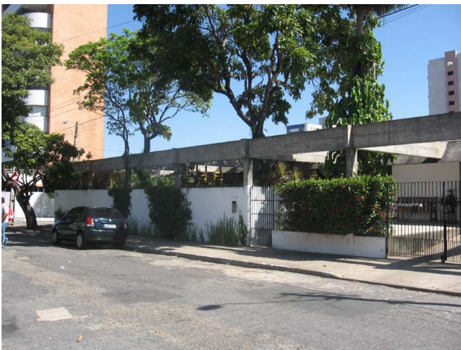
Figura 8 - Residência Rui Amauri Castelo, 1972. Fonte: Acervo pessoal José Furtado Filho
