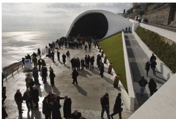
Figura 1: Auditório Oscar Niemeyer na cidade de Ravello na Itália: dramatização dos espaços
