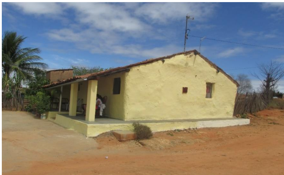
Figura 35 - Casa de taipa a mão, rebocada e pintada, quilombo Carcará
