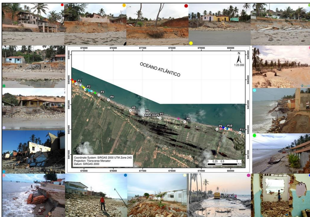
Figura 40: Destruição causada pela erosão no trecho monitorado do município de Icapuí.
