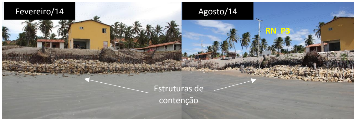
Figura 62: Estruturas de contenção da erosão no ponto de monitoramento 3 em 2014.
