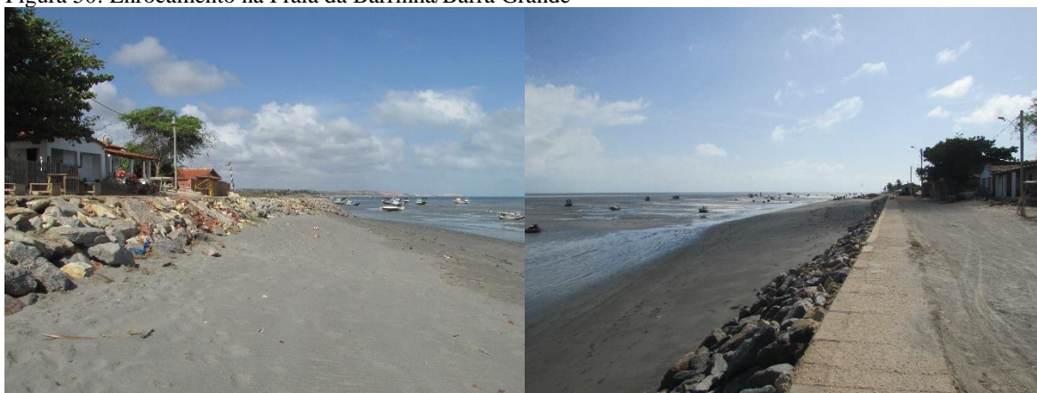
Figura 50: Enrocamento na Praia da Barrinha/Barra Grande
