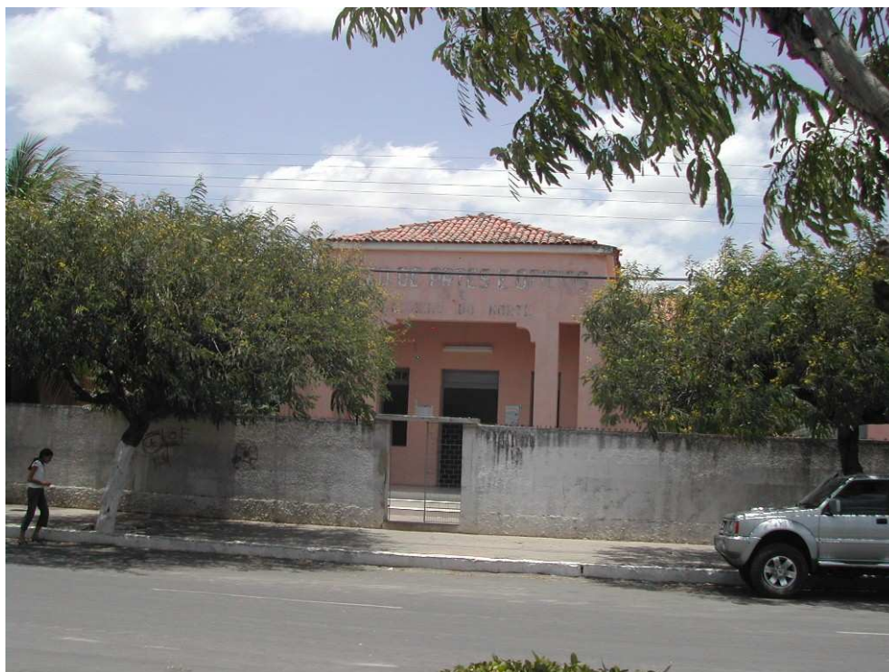
Prédio do Liceu de Artes e Ofícios, em Limoeiro do Norte, atualmente suas oficinas não funcionam mais e estão em péssimo estado de conservação, a entidade civil que o mantém, cedeu o prédio a Prefeitura do município para o funcionamento de turmas do ensino fundamental. Foto do acervo do autor.
