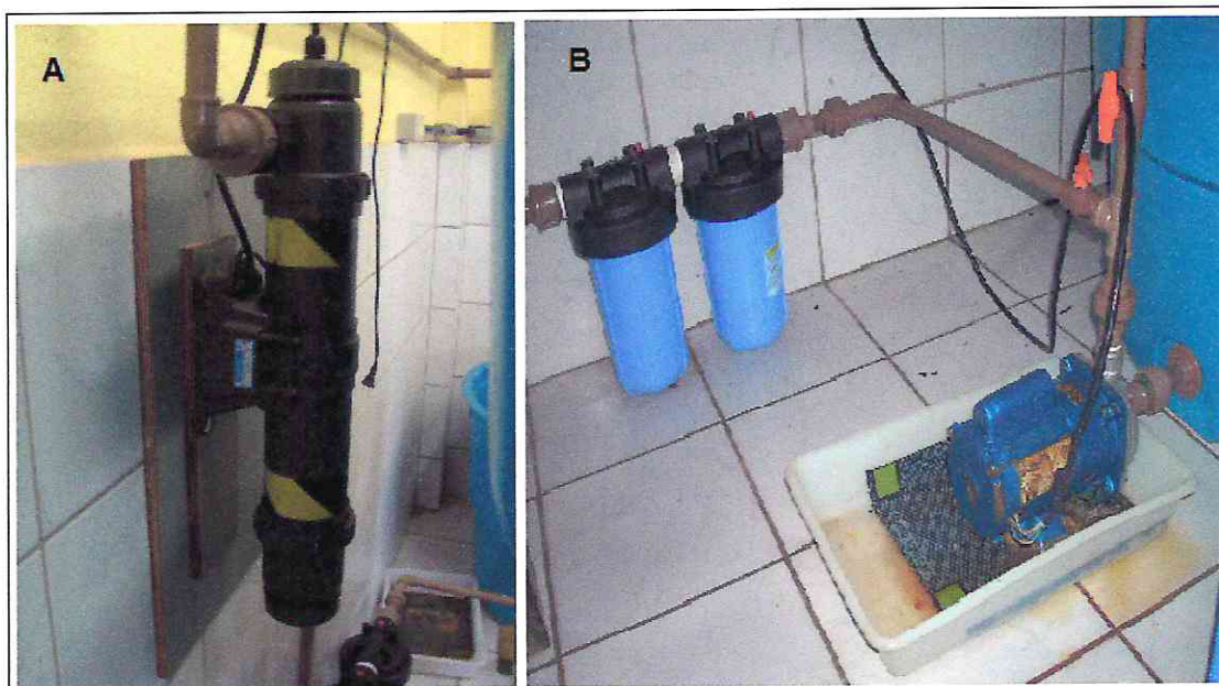
Figura 11: Sistemas de tratamento de água da sala de larvicultura: (A) - UV ; (B) - filtros de cartucho (10 e 30 \mu m).
