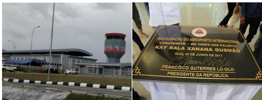
Figura 80—Pista de Aeroporto de Suai-Covalima, Costa Sul. Foto: Google 2017.
