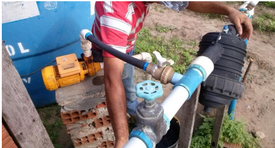
Figura 13 – Cabeçal de controle e sistema de injeção de fertilizantes, Fortaleza, Ceará, 2015
