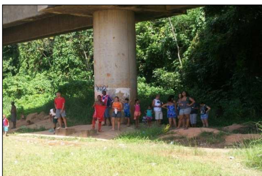
Figura 46. Fonte: Arquivo Pessoal. 2011. Obras do Metrô.
