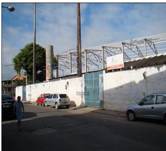
Figura 58. FONTE: http://fgretiro.blogspot.com/2010_07_01_archive.html . Acesso 27 set. 2011. Estrutura metálica do galpão em construção no antigo campo de futebol e quadras da Empresa Gráfica da Bahia.
