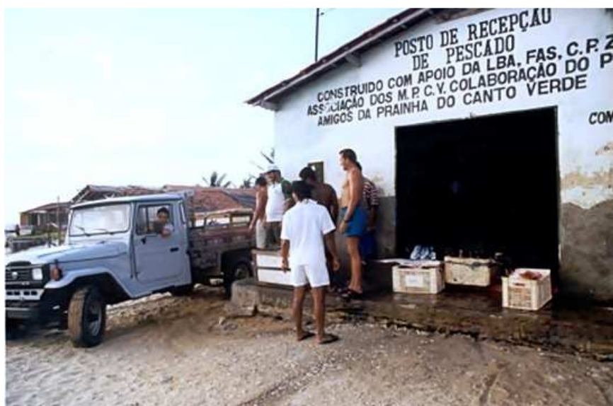
Foto 28: Prédio onde funcionava o Entrepósito (1993-2004) Fonte: Acervo Terramar
