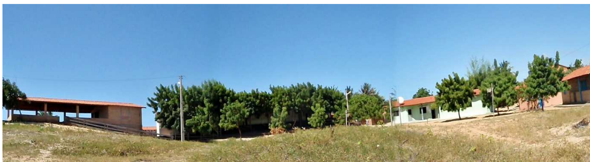
Foto 26: Vista panorâmica das instalações da Nova Escola da Prainha Fonte: Acervo Terramar
