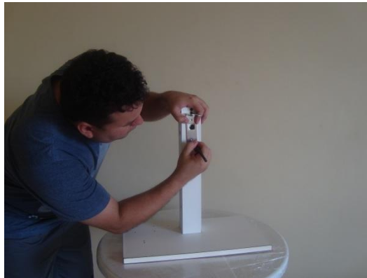
Figura A.1: 1° Passo de montagem após a confecção do suporte: Marcações
