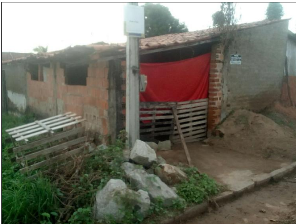
Figura 18 – Condições precárias de habitação, reflexo da situação de vulnerabilidade.
