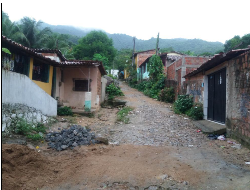
Figura 27 – Casas em situação de risco por estarem em áreas de elevação topográfica.
