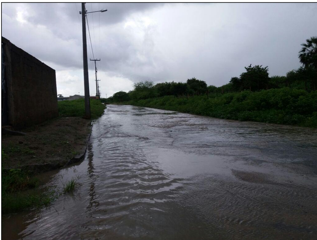
Figura 23 – Drenagem urbana deficiente.
