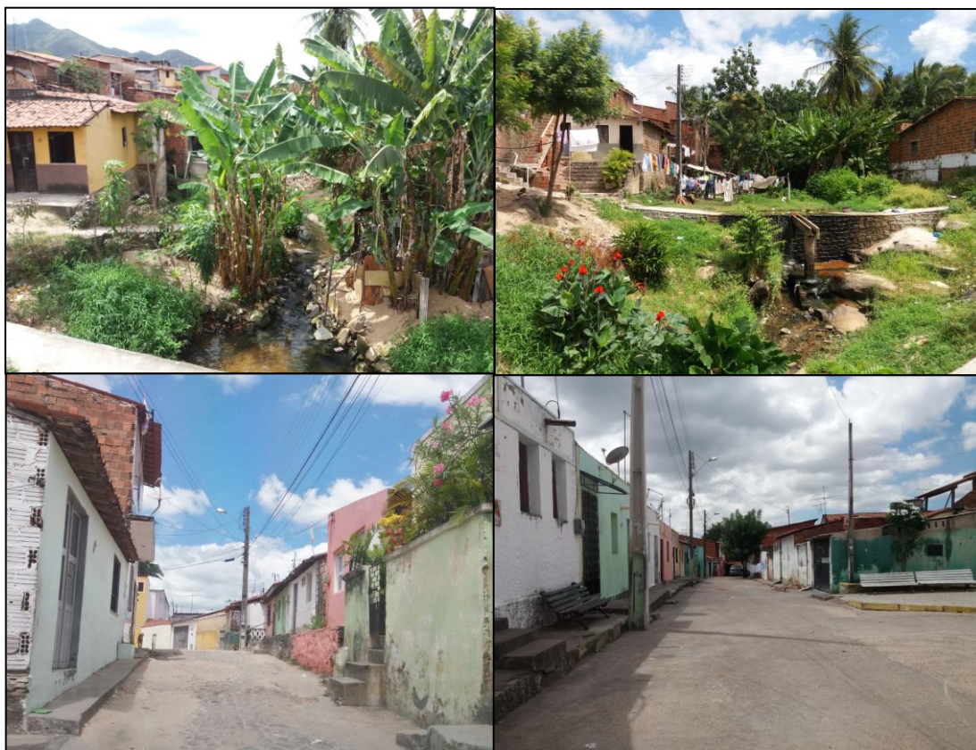
Figura 26 – Casas em situação de risco por estarem nas planícies fluviais.
