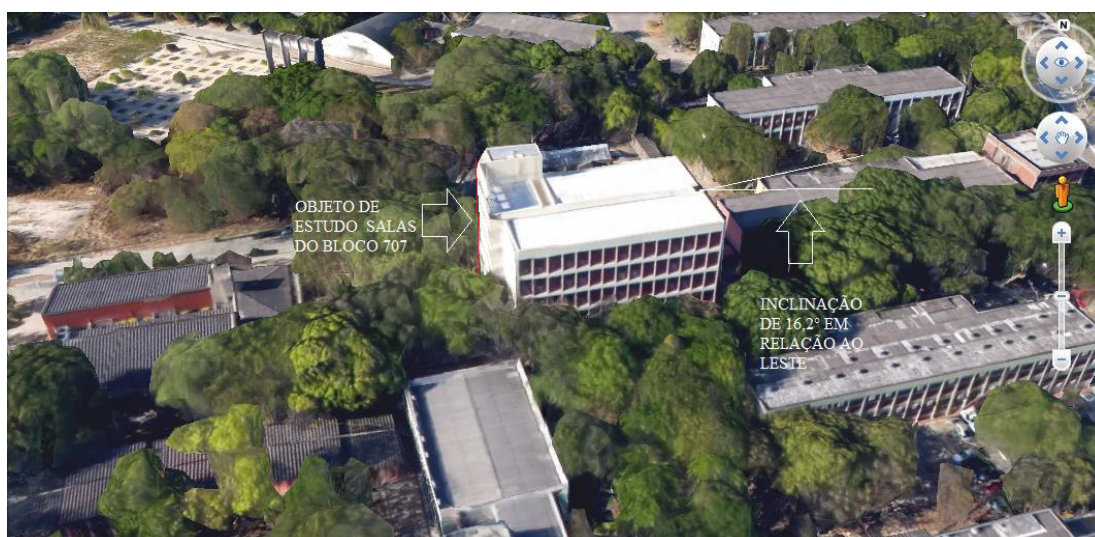
Figura 8: Vista externa da edificação.
