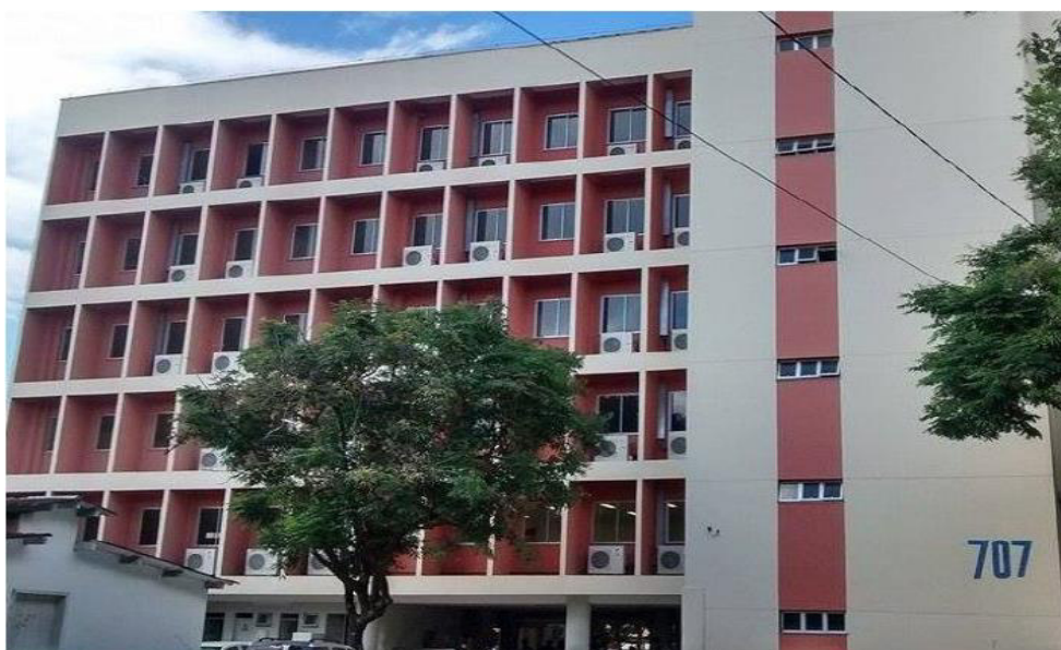
Figura 7: Imagem da edificação em estudo
