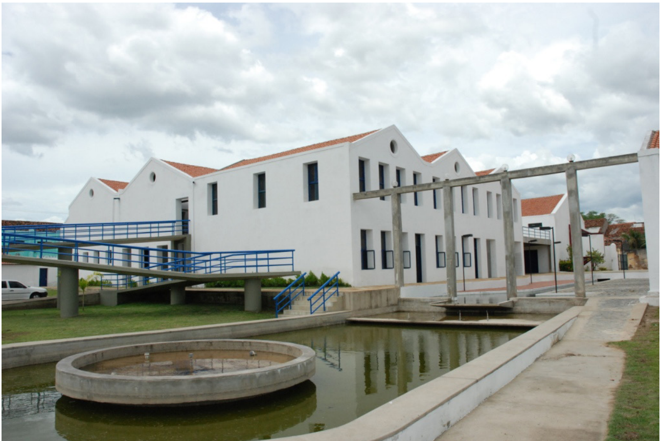
FIGURA 53 Escola de Cultura, Comunicação, Ofícios e Artes (ECO A). Fonte: http://brasilarquitectura.com/projetos/conjunto-kkkk-e-parque-beira-rio .
