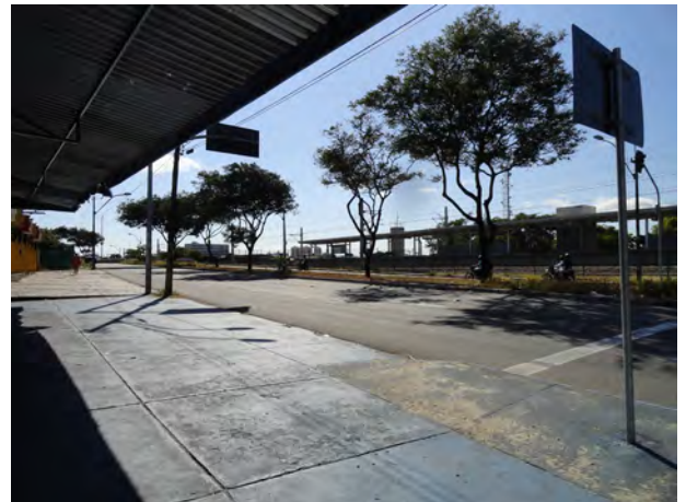
▲ IMG 57. Situação do terreno com relação à estação.
