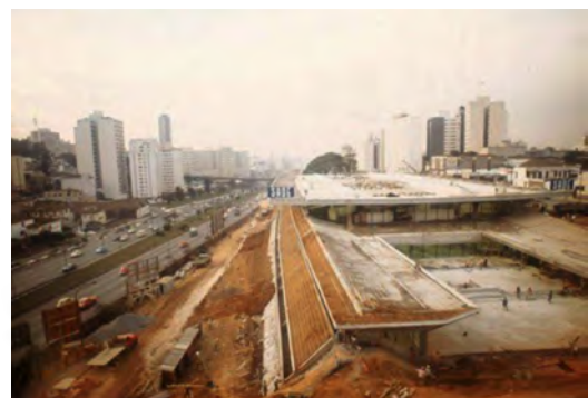
▲ IMG 38. CCSP construção.
