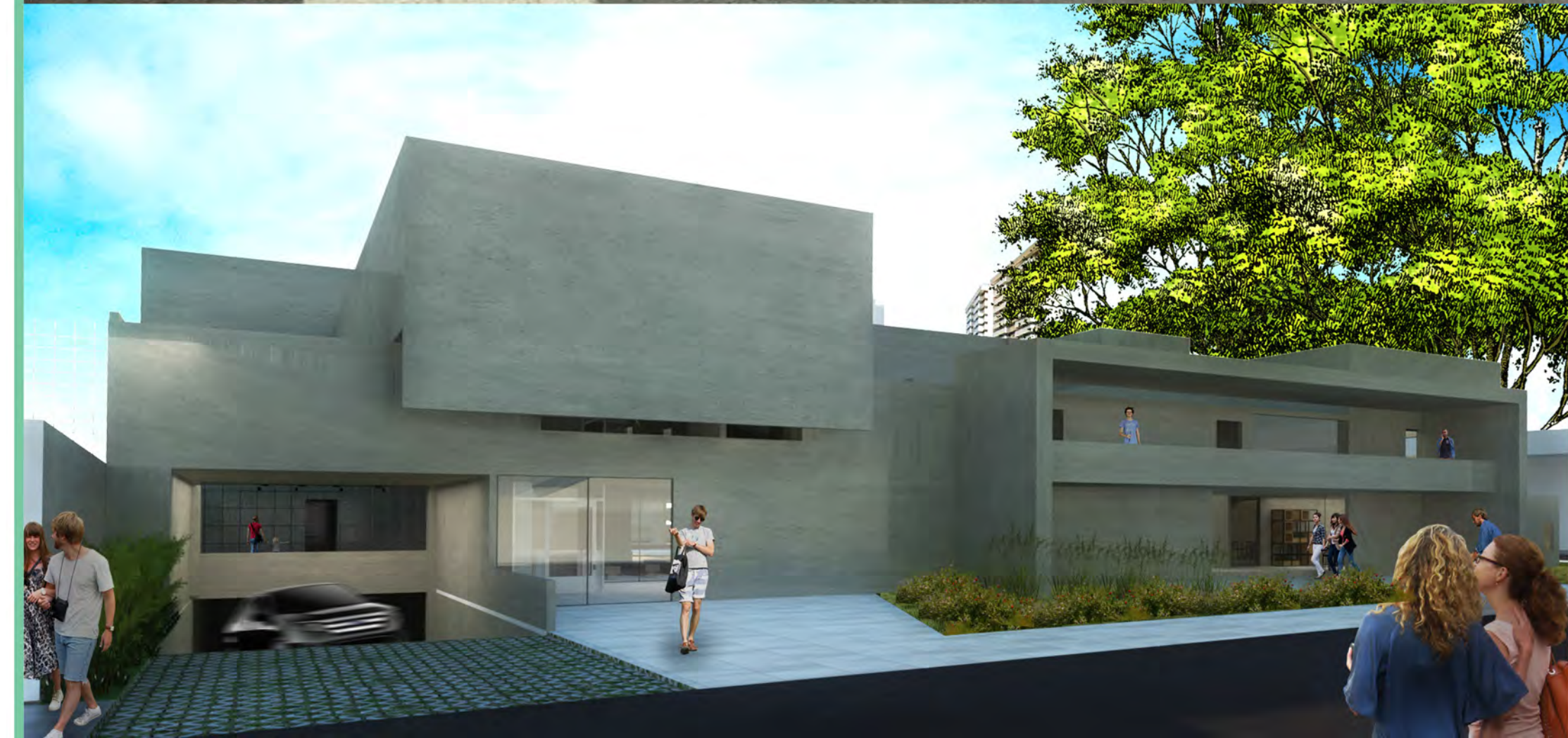
FACHADA POSTERIOR | Perspectiva da fachada posterior voltada para rua Capitão Francisco Pedro. À esquerda vê-se o acesso de veículos e acima o volume da biblioteca, com esquadria protegida pelo caimento do bloco de teatro. À direita a passarela conecta os blocos de exposição e oficinas.
