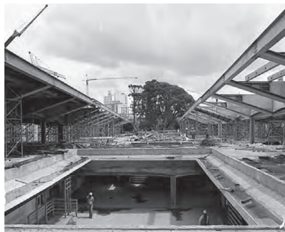
▲ IMG 40. CCSP construção estrutura.
