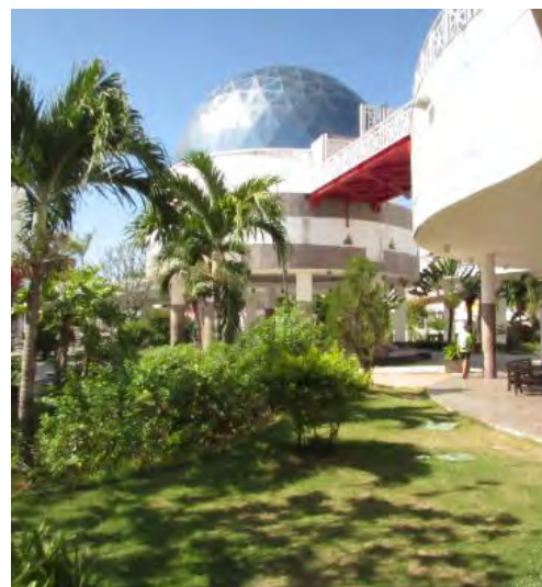
▲ IMG 23. Centro Cultural Dragão do Mar. Planetário.
