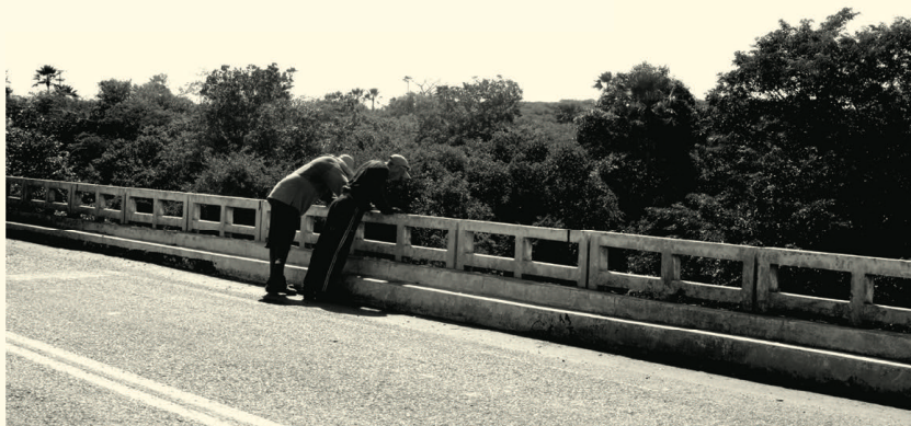
imagem 01: Ponte sobre o rio Groaíras, rodovia CE-179, 2017.
