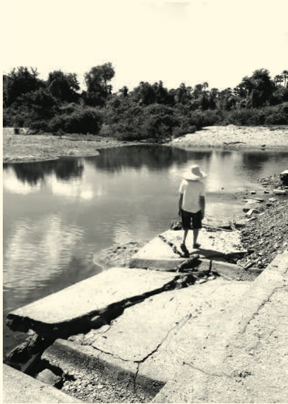
imagem 17: barragem sobre o Rio Groaíras, estrada Arial, 2017.
