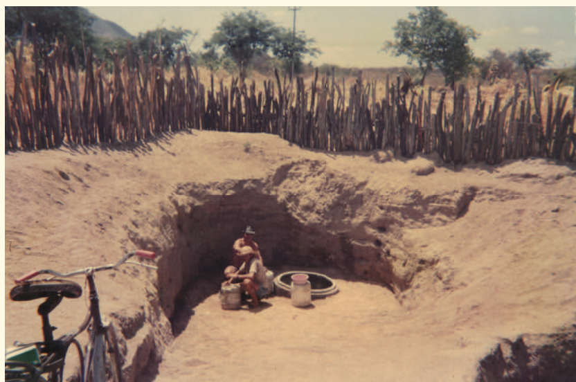
imagem 02: construção de fosso, fevereiro de 93.
