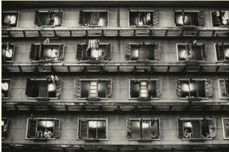
imagem 04: Os camponeses acostumados à sentar no parapeito das janelas de suas casas rurais, continuam à fazê-los nos edificios de apartamentos. Ho Chi Minh, Vietnã. 1995
