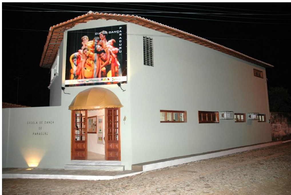
Figura 3 – Vista frontal da Escola de Dança de Paracuru
