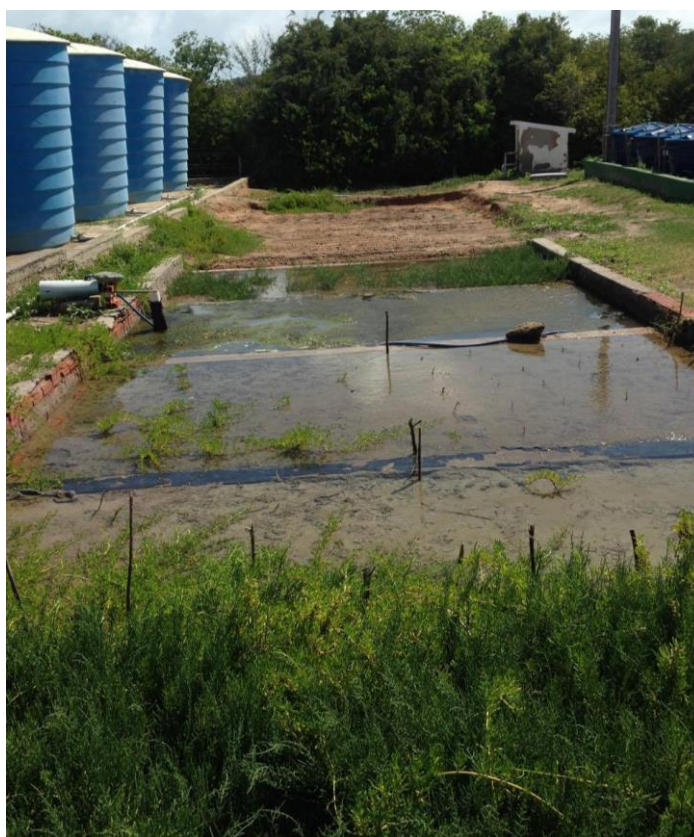
Figura 4 - Bacia de sedimentação contendo halófitas aquáticas para passagem de efluentes do LANOA.
