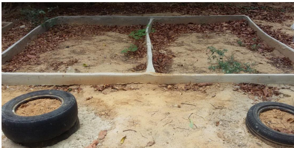
Figura 32 – Canteiro de ferrocimento.
