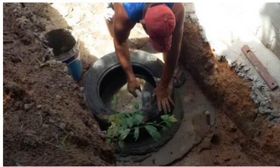
A – Fixação do pneu na laje.
