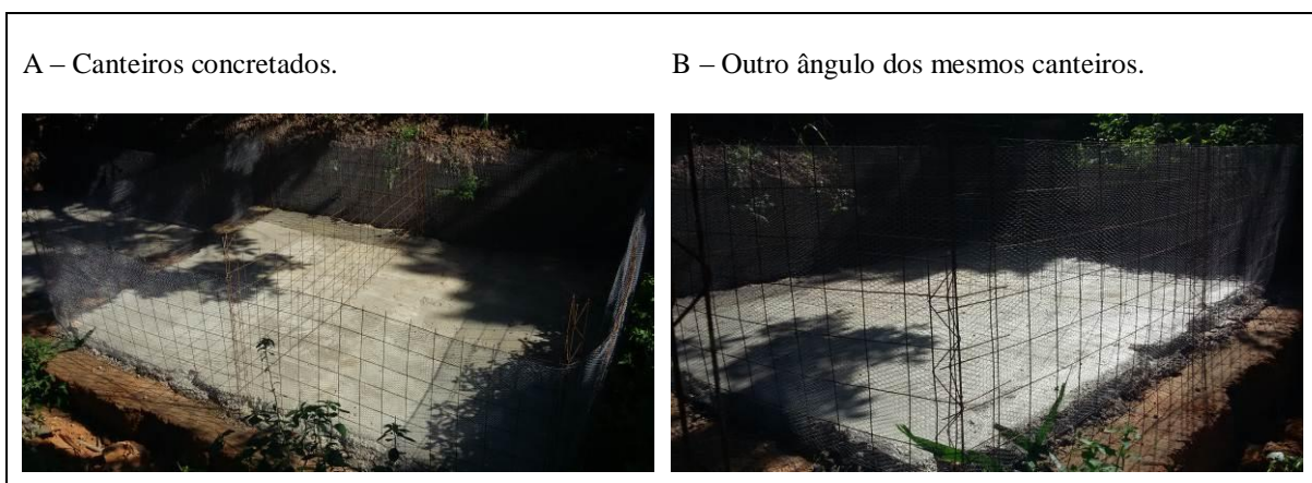
Figuras 11 – Laje de ferrocimento.
