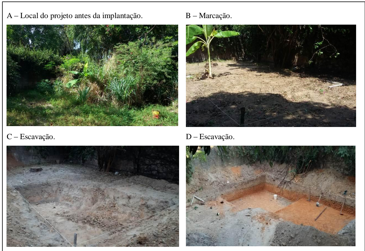
Figuras 5 – Marcação e escavação da área.
