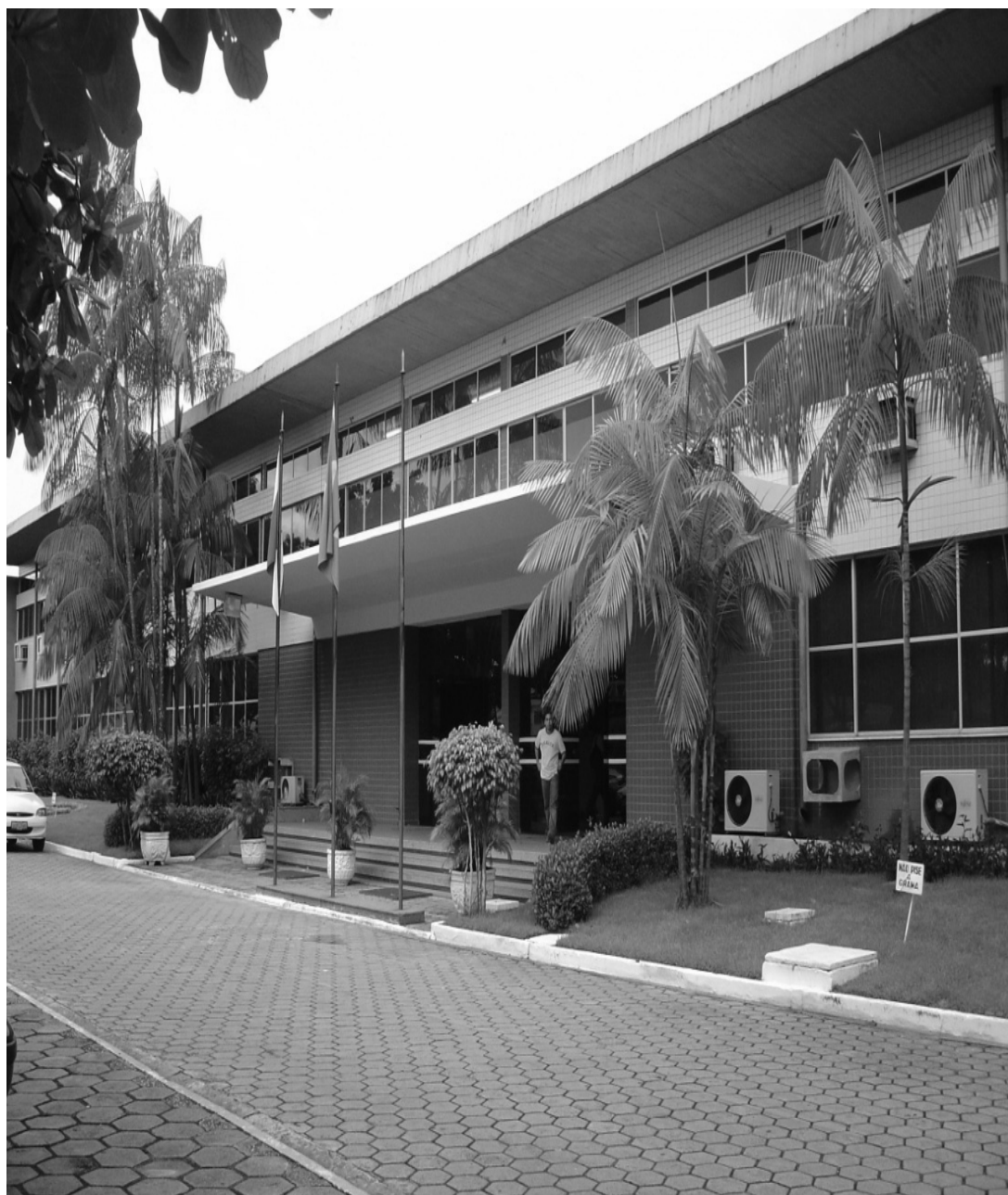
Figura 3: Fotografia da Fachada do IFPA, Atual Campus Belém, em 2009. Antiga sede da Escola Técnica Federal do Pará, cuja construção teve início no ano de 1965. Fotografado por: José Raimundo Carvalho.
