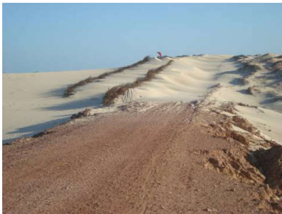
Figura 17 – Exemplo de duna móvel soterrando via de acesso para implantação de usina eólica (campo de dunas Cumbe/Canoa Quebrada), em Novembro/2009.
