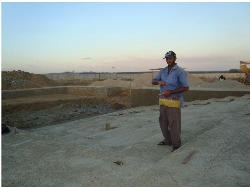
Ilustração 15 - Construção da nova escola para o Assentamento Santana. Local do anfiteatro.
