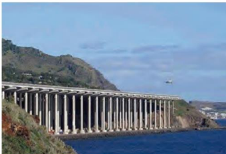
Figura 2 – Estrutura hiperestática da ilha da madeira
