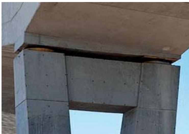
Figura 3 – Apoio entre o tabuleiro e um pilar em uma ponte de concreto pré-moldado
