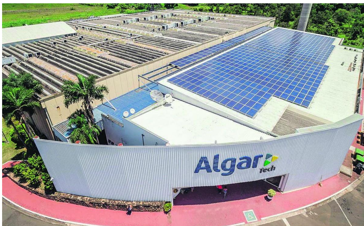
Figura 1.5 – Sistema fotovoltaico para alimentar o datacenter da empresa Algar Tech
