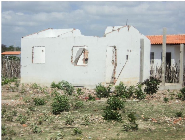
Fotografia 7 – Casa no Assentamento Massalina, após a retirada da cobertura, portas e janelas
