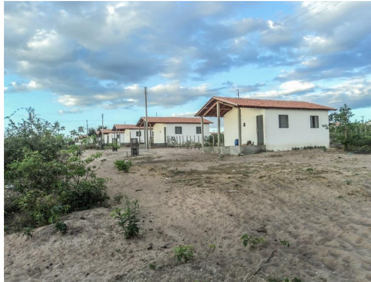
Fotografia 6 – Casas no Assentamento Jacaré 46
