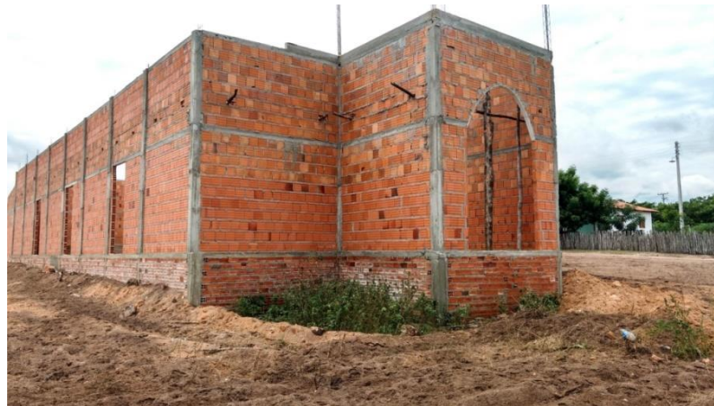
Fotografia 11 – Igreja Católica em construção no Assentamento Jacaré
