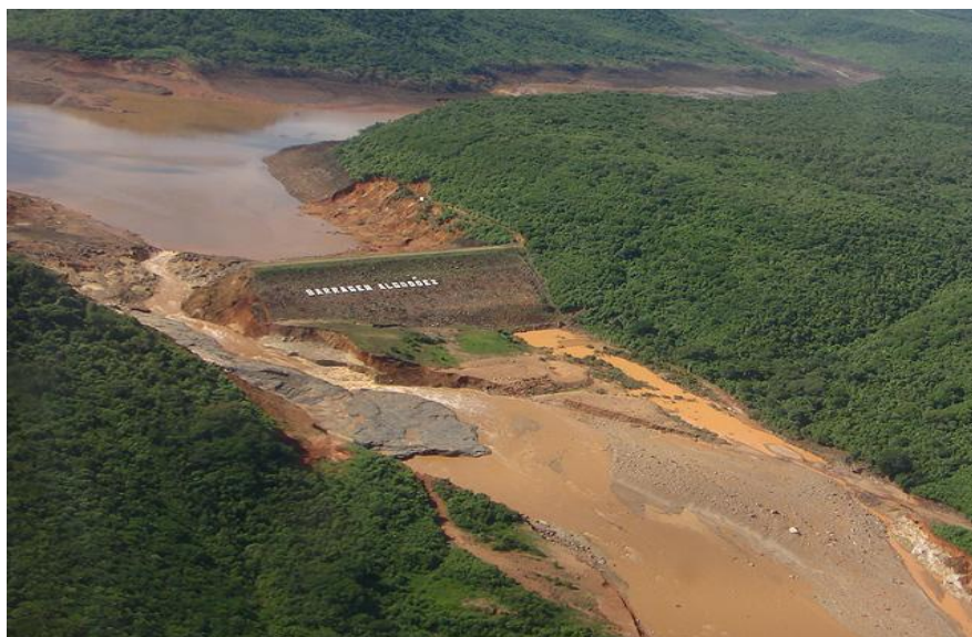
Fotografia 1 – Barragem Algodões I, após seu rompimento em 2009
