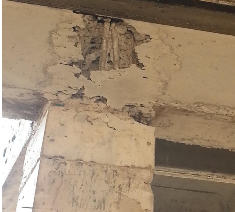
Figura 23 - Manifestação patológica na viga com CCV
