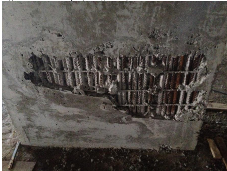
Figura 24 - Manifestação patológica no pilar com CCV
