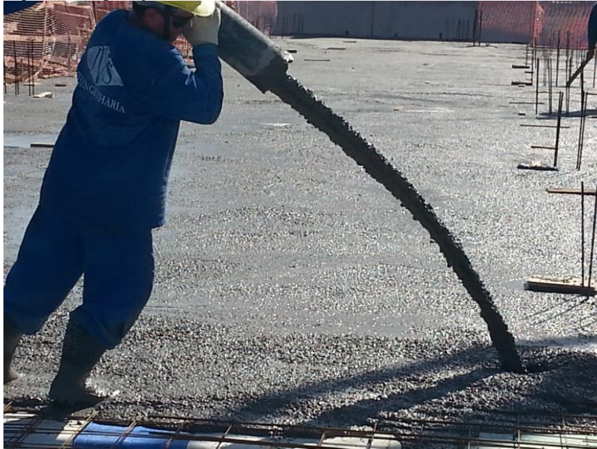
Figura 20 - Aplicação do CAA na obra
