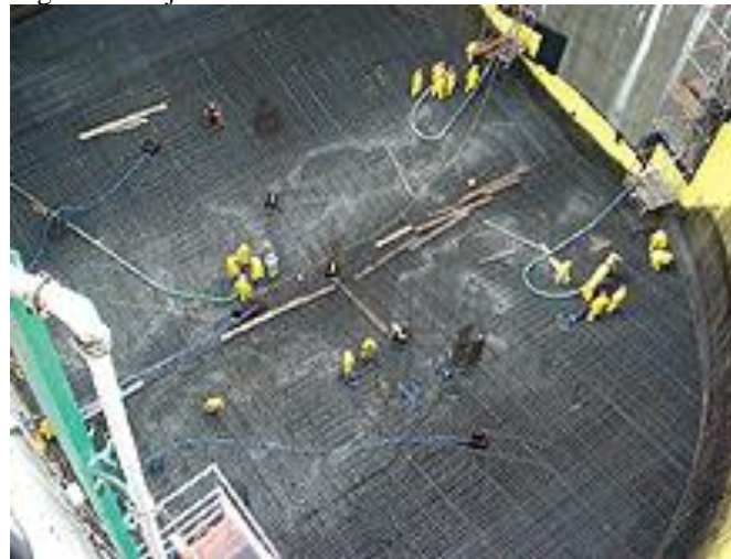
Figura 8 - Laje do metrô de São Paulo
