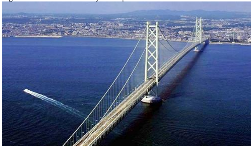
Figura 6 - Ponte Akashi-Kaikyo no Japão
