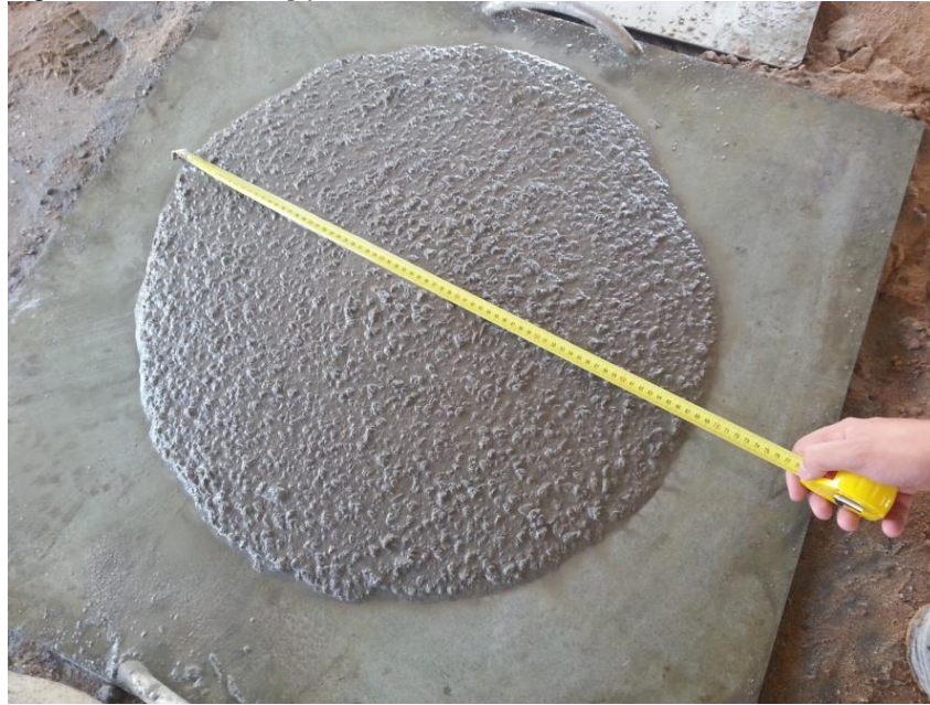
Figura 18 - Ensaio slump flow na obra
