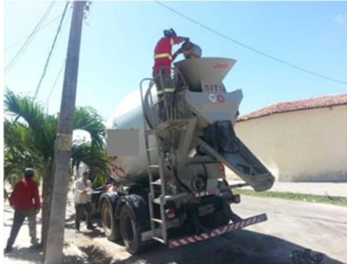
Figura 12 - Colocação do aditivo superplastificante na obra
