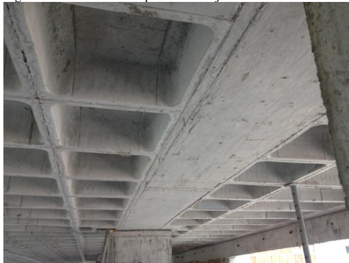
Figura 22 - Acabamento superficial da laje
