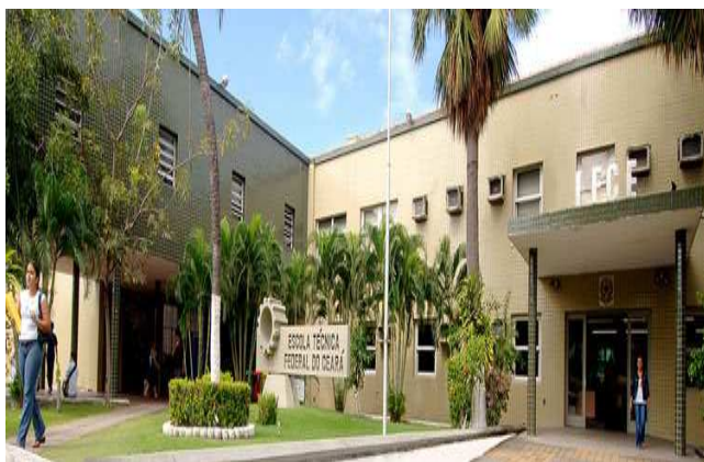
Figura 4 – Instituto Federal de Educação, Ciência e Tecnologia do Ceará – Campus Fortaleza Fonte: http://www.ifce.edu.br/_img/instituicao/sobre_nos/i_01.jpg
