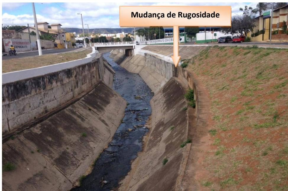
Nesta simulação adotou-se o número de Manning de  $0,013 \text{ m}^{1/3}\text{s}$  para as laterais e o fundo, nas seções correspondentes aos 935 metros recém reformado e para restante do canal com comprimento de 1305m. Adotou-se  $0,016 \text{ m}^{1/3}\text{s}$  para as laterais que corresponde a revestimento de concreto em condições regulares e para fundo do canal adotou-se  $0,025 \text{ m}^{1/3}\text{s}$ , aplicado em canais curvilíneos, lamosos e com presença de pedregulho.
