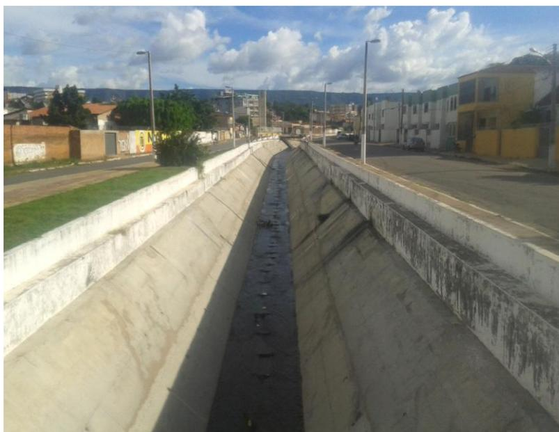
No trecho 2 de 1305m não houve reforma e o canal permaneceu com as mesmas condições estruturais. Atualmente o trecho 2 apresenta taludes revestido de concreto com características regulares e no fundo do canal trechos lamoso com pedregulho e vegetação rasteira, Figura 12.
