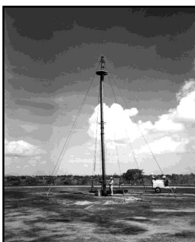
Figura 6: Mastro para amarração de Blimp na base Pici Field em Fortaleza.
