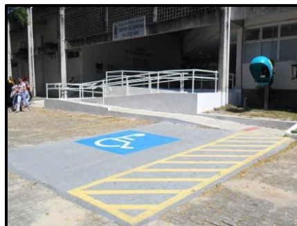
Figura 21: Estacionamento para pessoa com deficiência no CC
