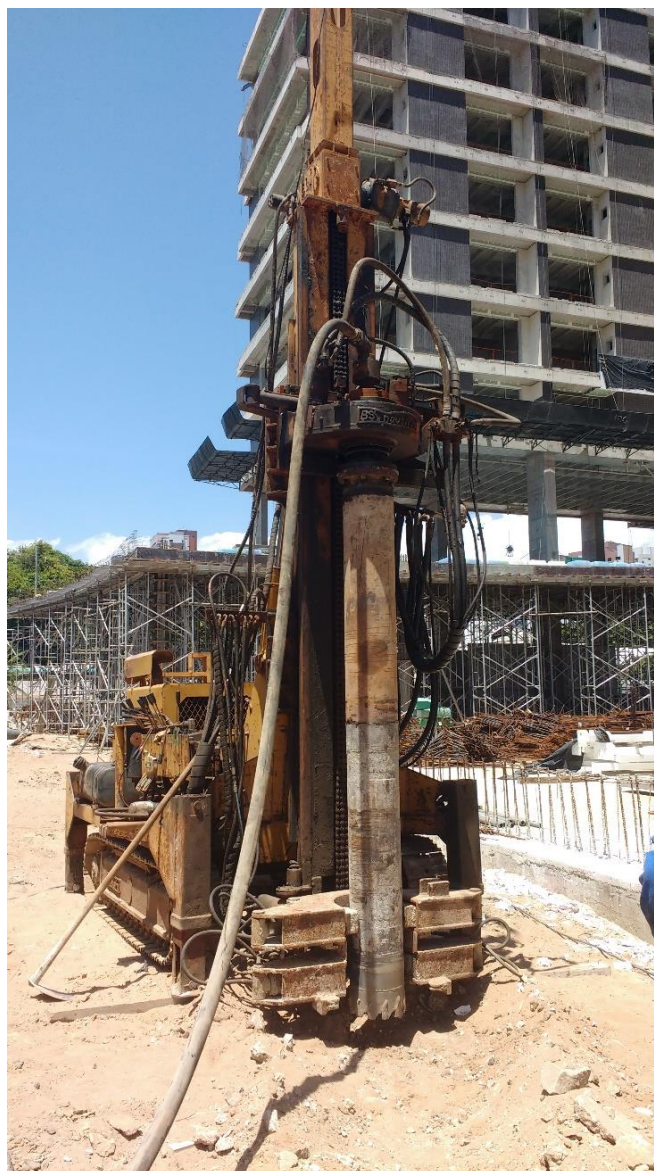
Figura 3.7 – Perfuratriz utilizada para execução das estacas raiz
