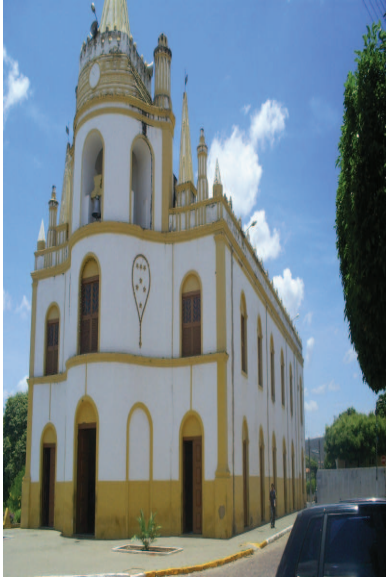
Figura 20 – Igreja de Nossa Senhora do Rosário em Barbalha-CE.
